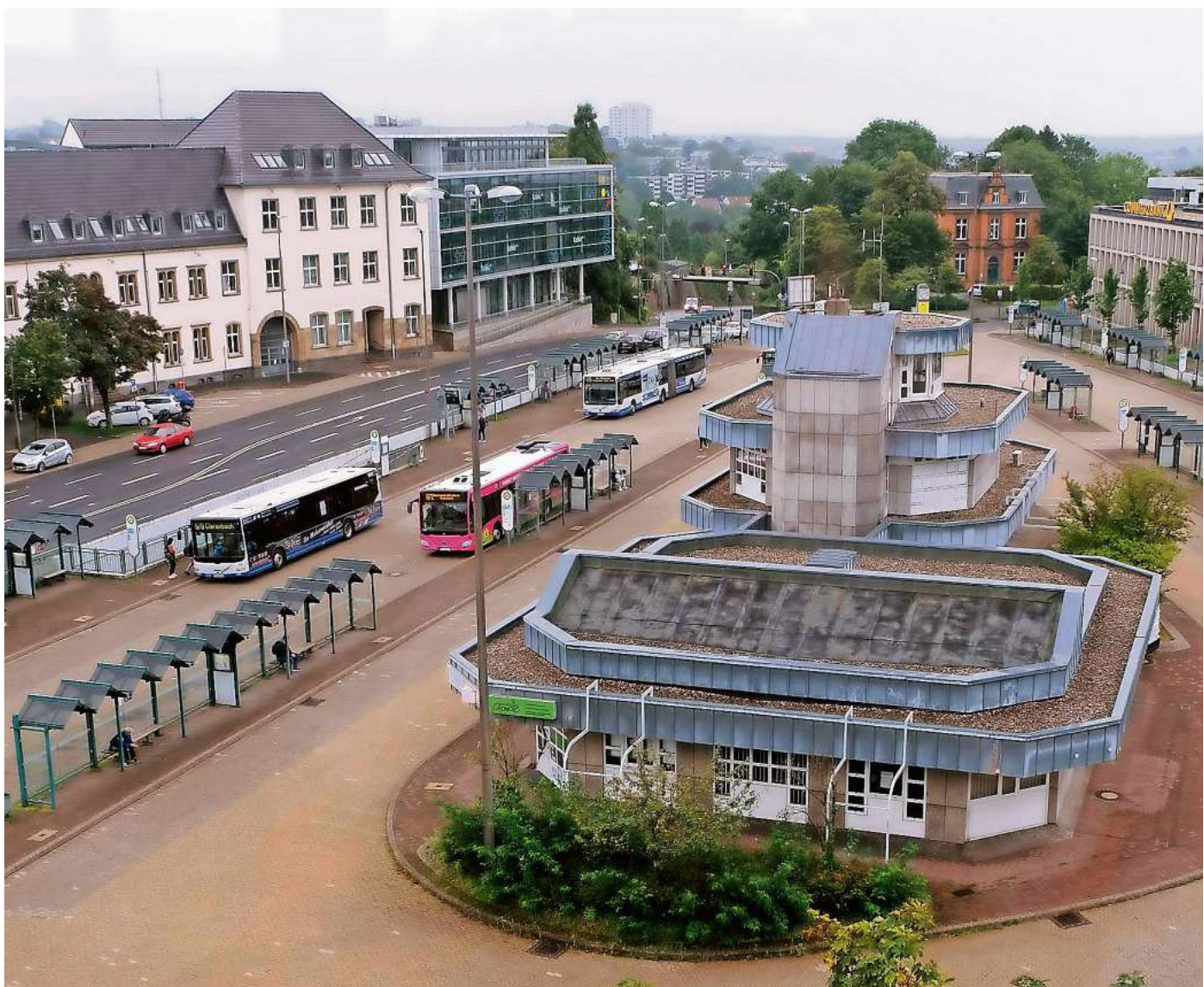
Das Betriebsgebäude wird im Oktober abgerissen. In einigen Jahren soll die Unterführung verschwinden.
